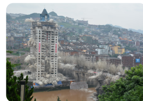
爆破工程一体化服务产业——茅台酒厂钟楼和茅台大桥爆破拆除
